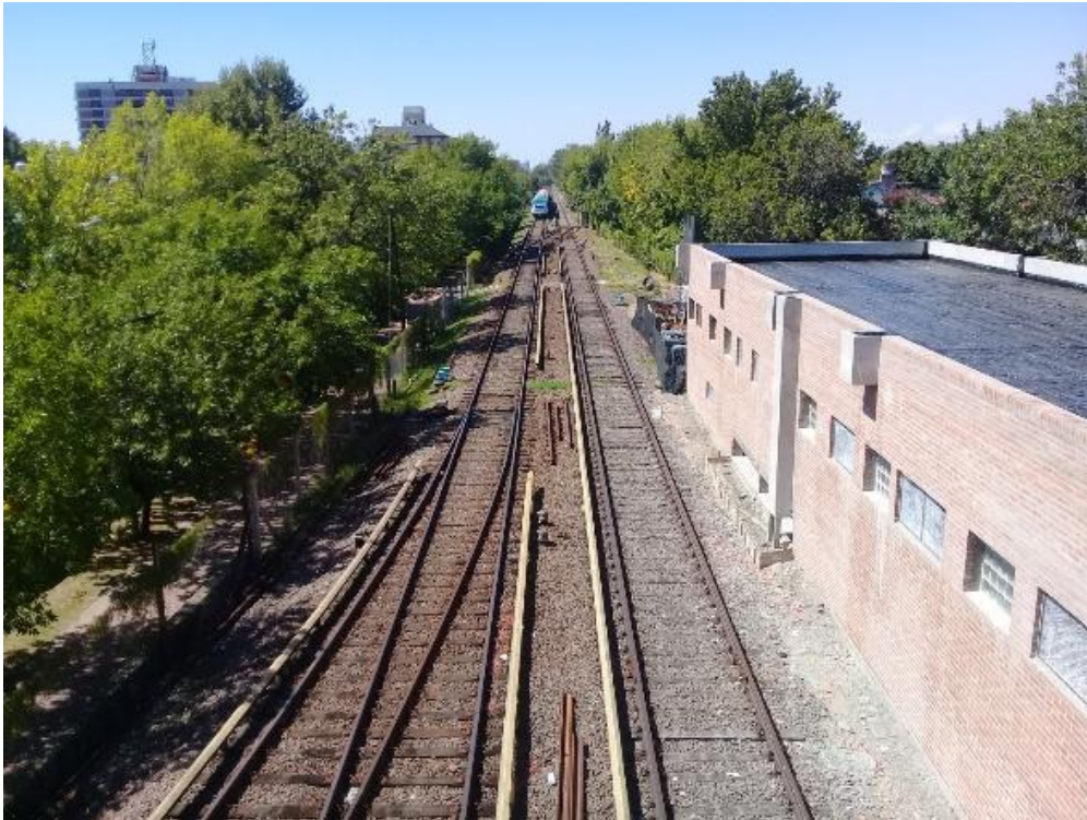
Fotografía 8. Proximidades de estación Tigre. Vista desde puente peatonal PK 27,675 (aprox.) en sentido descendente.
