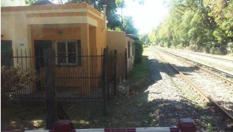
Fotografía 5: Construcción con leve avance sobre zona de vía. PK 17,667 intersección calle Repetto (San Isidro).
