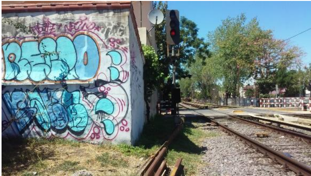
Fotografía 7. Construcción a 2 metros de la vía. PK 25,337, próximo a intersección con calle Quirno Costa.
