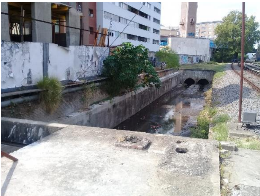
Fotografía 3. Infraestructura hidráulica en PK 15,063 (Altura PaN Roma)
