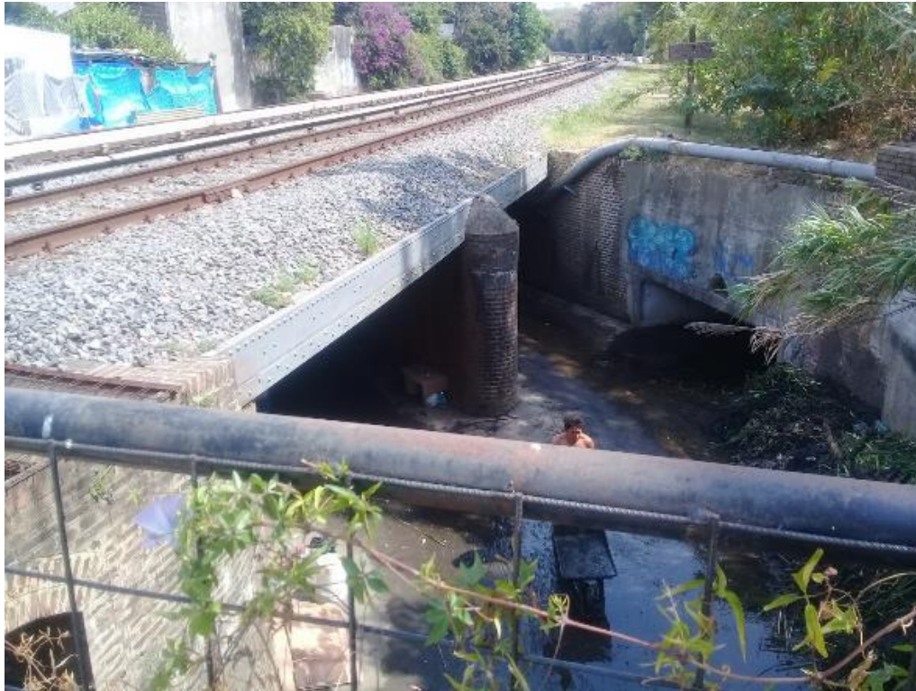
Fotografía 2. Infraestructura hidráulica en PK 15,063 (Altura PaN Roma).
